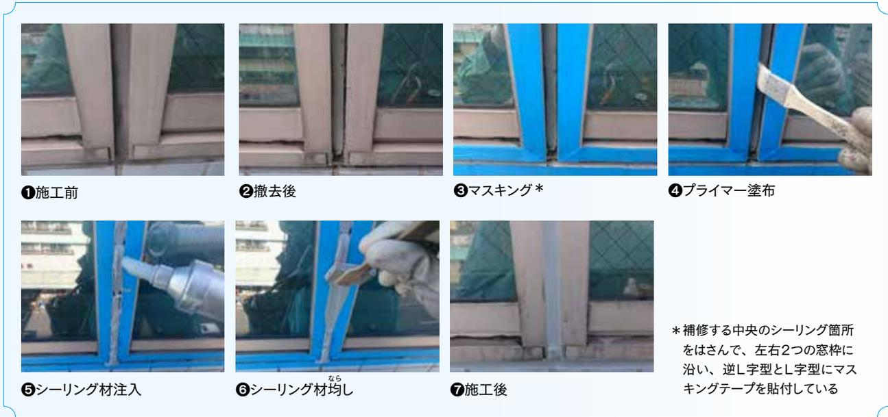
この工程をロープ作業で行う場合、タイル補修時と同様に安定性が悪く、力を入れにくいことが問題となり、平場施工時よりも作業効率が悪くなります。
