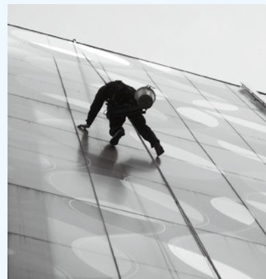
(写真3) 目地 建物の縦横に入ったライン
