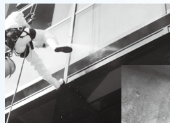
漏水の疑いのある箇所に、直接水を撒いて確認する
