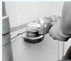
①欠損脆弱部をサンダーで切除
