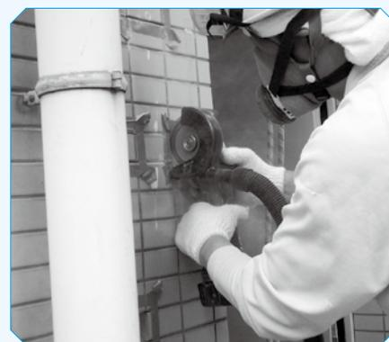
(写真1) サンダーを使ったタイル剥がし作業
