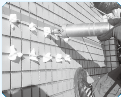
(写真3) エポキシ樹脂をガンで注入
