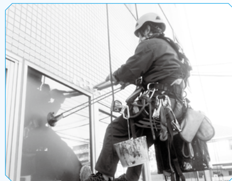
(写真5) 吸盤を使った作業
