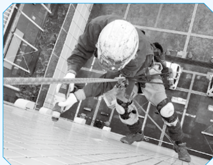
(写真2) 目地にドリルで穴あけ
