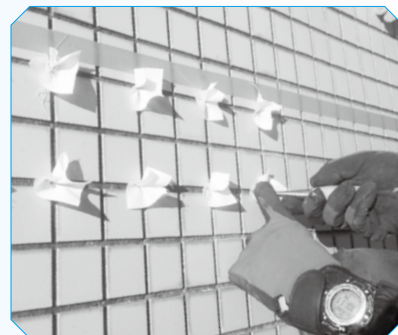
(写真4) ステンレスピンの挿入
