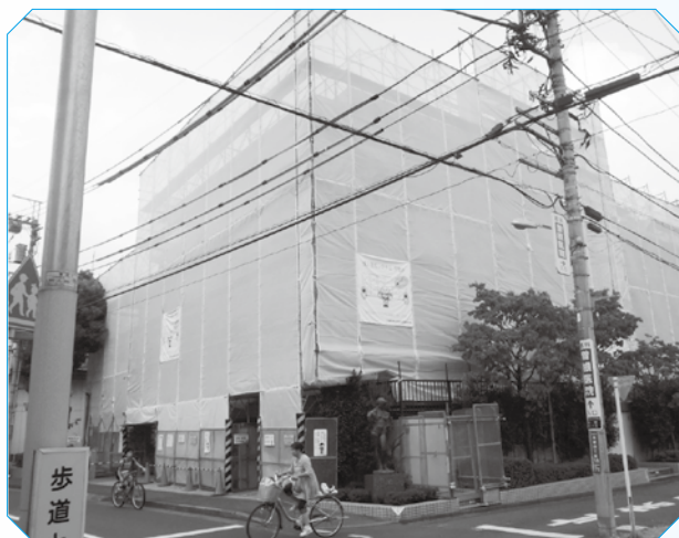
(写真1) 仮設足場ネット付
