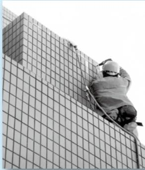
①深目地のエフロはルーター（軸付砥石）等を電動工具に取り付けて切削する
