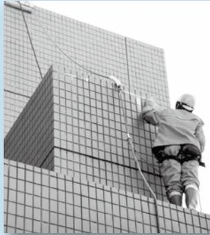
②目地部のエフロをある程度削り取ってから、スルファミン酸等によるケミカル反応を促す
