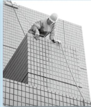
③ケミカル反応にあわせて、酸化アルミナ含有の研磨パッドも使用、物理的作用で補う
