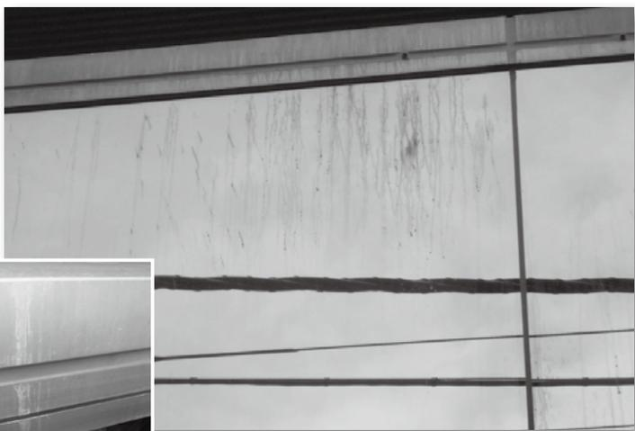
**症状** 建物の外壁洗浄を行った後、窓ガラスと窓枠のサッシに、液ダレのような黒い痕が残っています。窓ガラスは、外ネッパン（外側に酸化皮膜施工された熱線反射ガラス）です。
