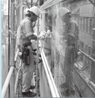
①酸化セリウムを研磨剤として、ハンドポリッシャー（白パッドかフェルトパッド）で研磨していく
