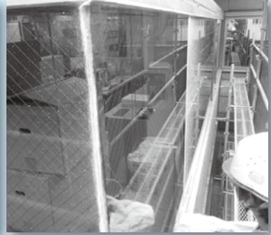
③研磨終了後のガラス（中央）。酸化皮膜が剥離されたことが確認できる（当該建物のネッパンは部分的に網入りガラスも混在）
