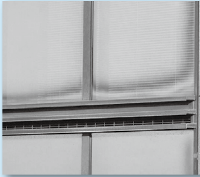
写真1 熱線反射ガラスの劣化（虹彩現象） ネッパンガラスの縦枠、下部水切り周辺に虹色に発生している
