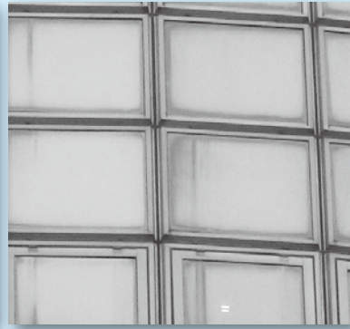
写真1 熱線反射ガラスの劣化（虹彩現象） ネッパンガラスの縦枠、下部水切り周辺に虹色に発生している
