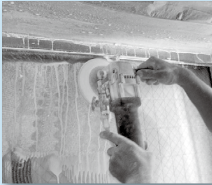
写真1 研磨作業の様子。養生を十分に 行い、パッドを取り付けた研磨機で磨く
