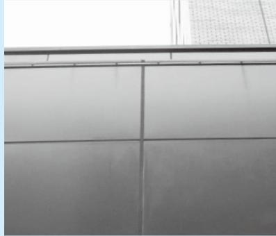
〔1〕建物3階より上部がセットバック（後退）した構造のため、2階上部で見切り、1～2階部分のラスタertイルをアルミパネルでカバーした事例。3階から上部はラスタertイルのまま
