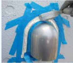
⑥シーリング材を均(なら)す
