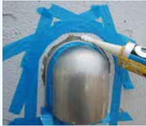
⑤シーリングを使用して接着
