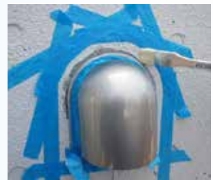
④周囲を養生し、プライマーを塗布
