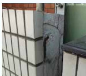
②爆裂表面のコンクリートのみ撤去
