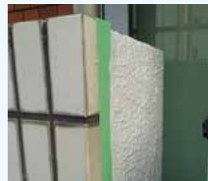
⑧砂骨ローラー(仕上げ塗装)後
