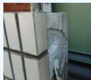
④エポキシ系プライマーの塗布
