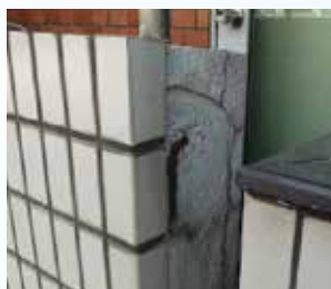
②爆裂表面のコンクリートのみ撤去
