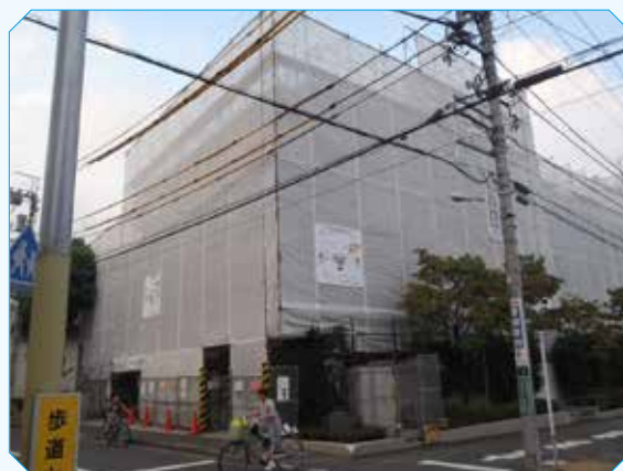
（写真1）足場を組む場合（仮設足場+養生ネット）
