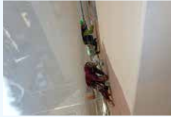
▲塗装作業の様子
