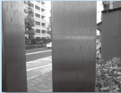
写真4 ステンレス製の道標、脚部 (ヘアライン) に発生した錆
