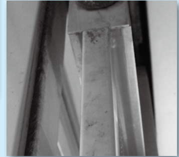
写真1 臨海地区に位置している建物玄関のステンレス建具（ヘアライン）※に発生した錆
