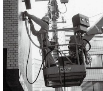
高圧洗浄と汚水回収（上から）可搬型ゴンドラを足場仮設とした作業
