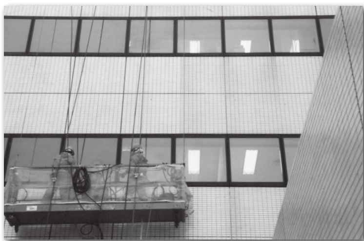
酸性洗淨剤による洗淨事例。 正面建物の右半分は洗淨前、左半分は洗淨後
