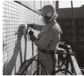
高圧洗浄と汚水回収（上から）可搬型ゴンドラを足場仮設とした作業
