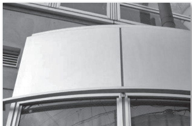
専用洗浄剤で汚染ファクターを除去し、表面保護処理を行うことで劣化した電着塗膜層を修復！美観は見違えるように回復し耐候性も向上！【結果】問題解決！
